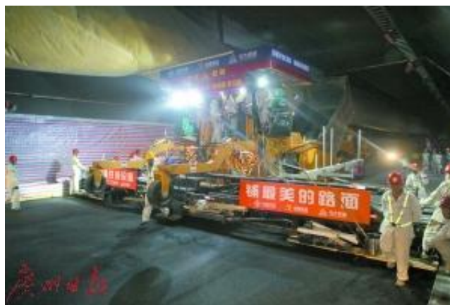
大桥建设者在海底举行路面铺装。
